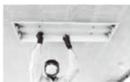
照明器具カバー、反射板などを取外す
